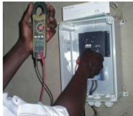
Installation d'un kit dans le village de Kotaga
